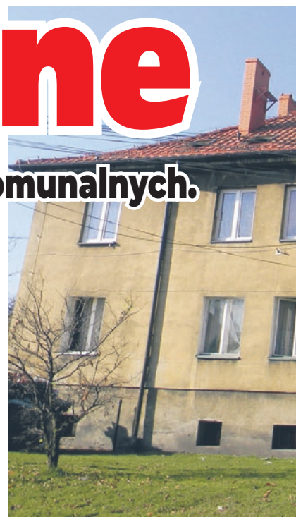
budynków jest już doprowadzona instalacja gazowa.
