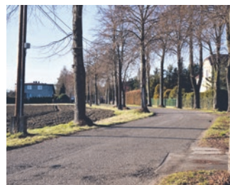
Roboty budowlane związane z ul. Tyską w Gostyni - 500 000 zł
