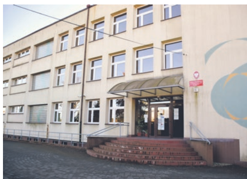
Rozbudowa budynku Szkoły Podstawowej w Gostyni wraz z termomodernizacją i zagospodarowaniem terenu - 3 912 283 zł
