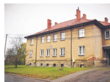
Termomodernizacja budynków komunalnych - mieszkalnych wielorodzinnych stanowiących własność gminy - 300 000 zł
