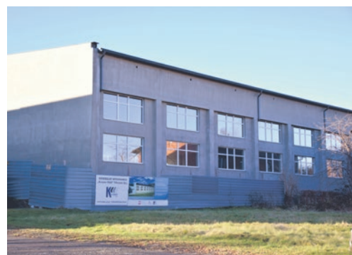
Budowa budynku sali gimnastycznej z łącznikiem wraz z zagospodarowaniem terenu przy Szkole Podstawowej w Wyrach przy ul. Puszkina 10 - 4 175 000 zł
