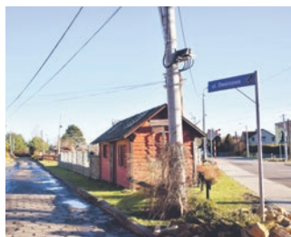
Przebudowa ul. Dworcowej w Wyrach - 585 300 zł
