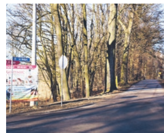
Przebudowa wylotu kanalizacji deszczowej przy ul. Motyla w Gostyni - 64 700 zł
