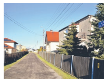
Przebudowa ul. Kopaniny - boczna w Wyrach (od nr 15 do 17) - 523 547 zł
