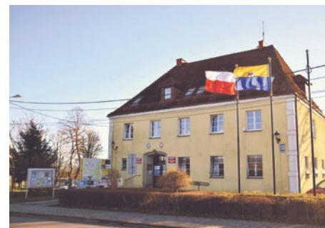
Wykonanie klimatyzacji w budynku Urzędu Gminy Wyry IV etap (I piętro) - 19 342 zł
