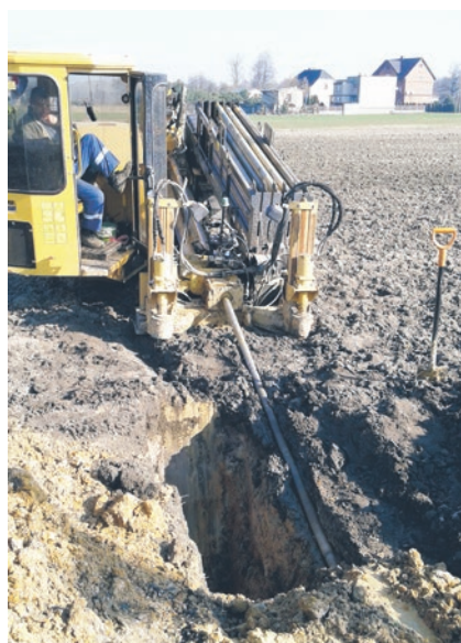
Budowa kanalizacji sanitarnej:
