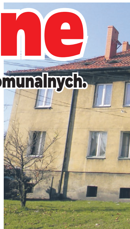
budynków jest już doprowadzona instalacja gazowa.
