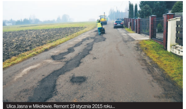
Ulica Jasna w Mikołowie. Remont 19 stycznia 2015 roku...
