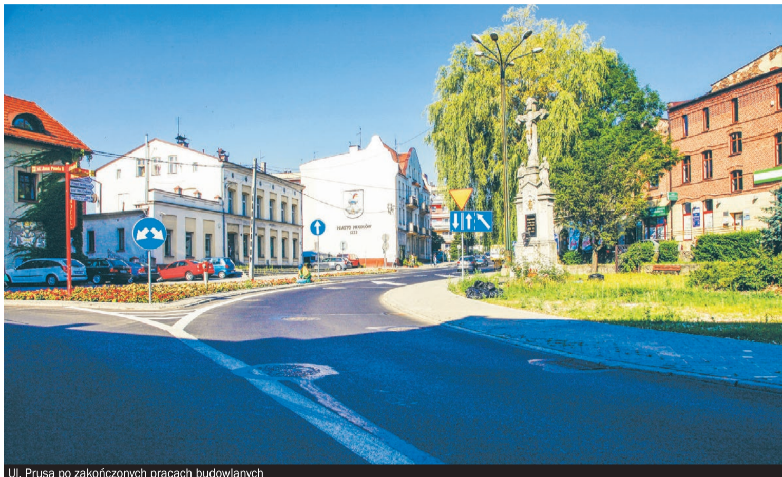
Ul. Prusa po zakończonych pracach budowlanych
