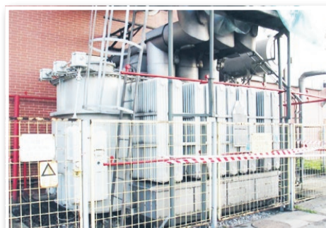
transformator blokowy
