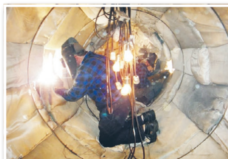
wymiana osprzętu wewnętrznego walczyka
