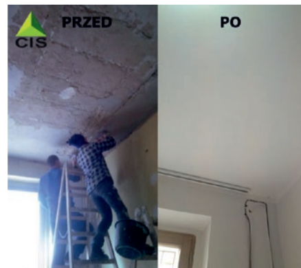
Uczestnicy grupy remontowo-budowlanej odnawiający pomieszczenia biurowe przy ul. Krawczyka 16.
