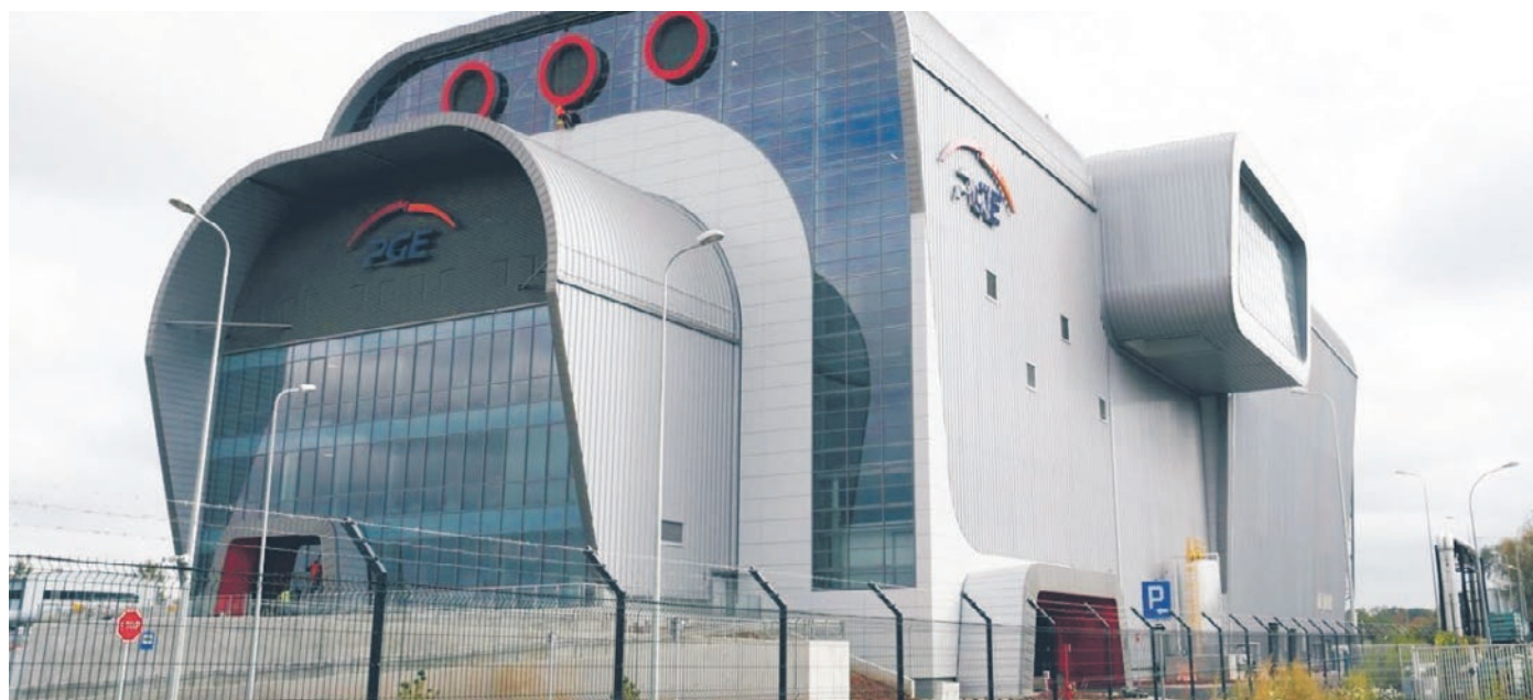
Instalacja do termicznej utylizacji odpadów przynajmniej częściowo rozwiązałaby problem śmieci na Śląsku i w powiecie mikołowskim. „Spalarnia” nie powstanie, ponieważ wojewodzie i Metropolii nie jest razem po politycznej drodze.
